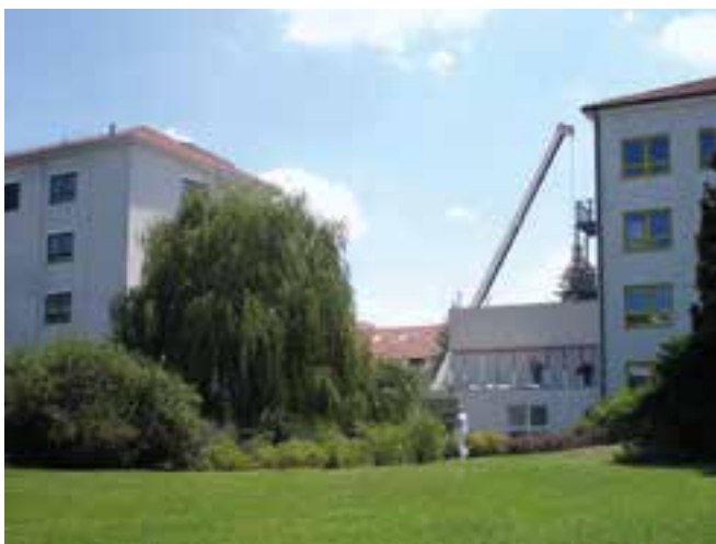
„V současné době probíhají práce na nadstavbě krčku mezi pavilony I a L.“
