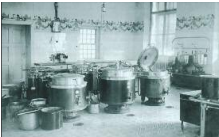
Původní nemocniční kuchyně.
