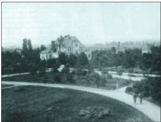
Infekční pavilon v době stavby nové nemocnice v roce 1914. Nyní je zde budova vedení společnosti.
