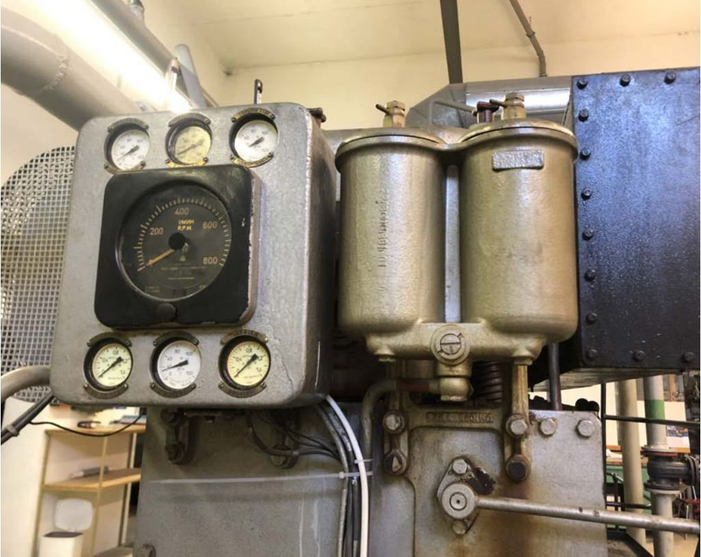
"Přístrojový panel" HAR II - otáčkoměr, tlakoměry a teploměry | Foto: Ing. Veronika Dubská
