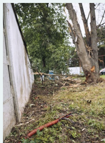
Detail vstupu bleskového proudu do kabelové sítě NCB z jiné perspektivy
